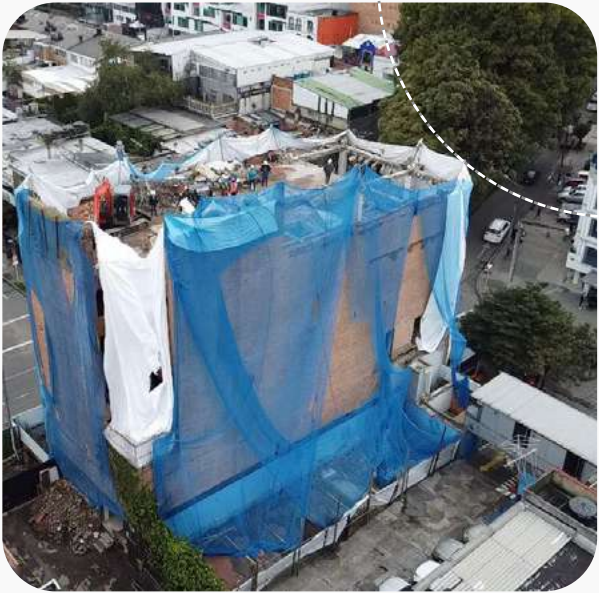
PREVIO A DEMOLICIÓN
