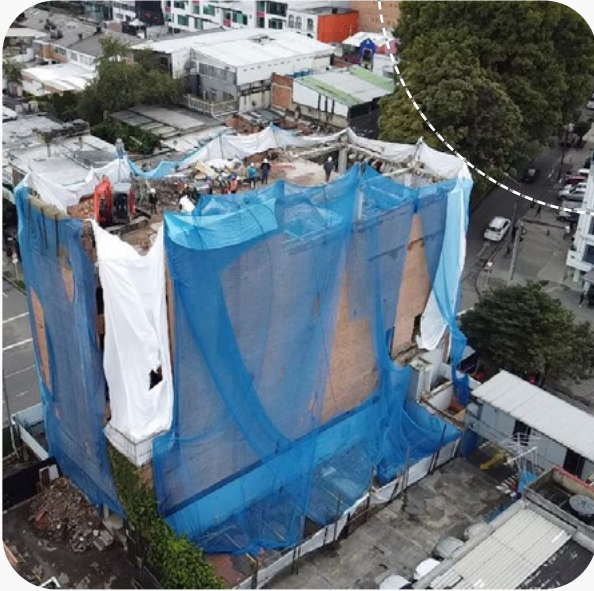
PREVIO A DEMOLICIÓN
